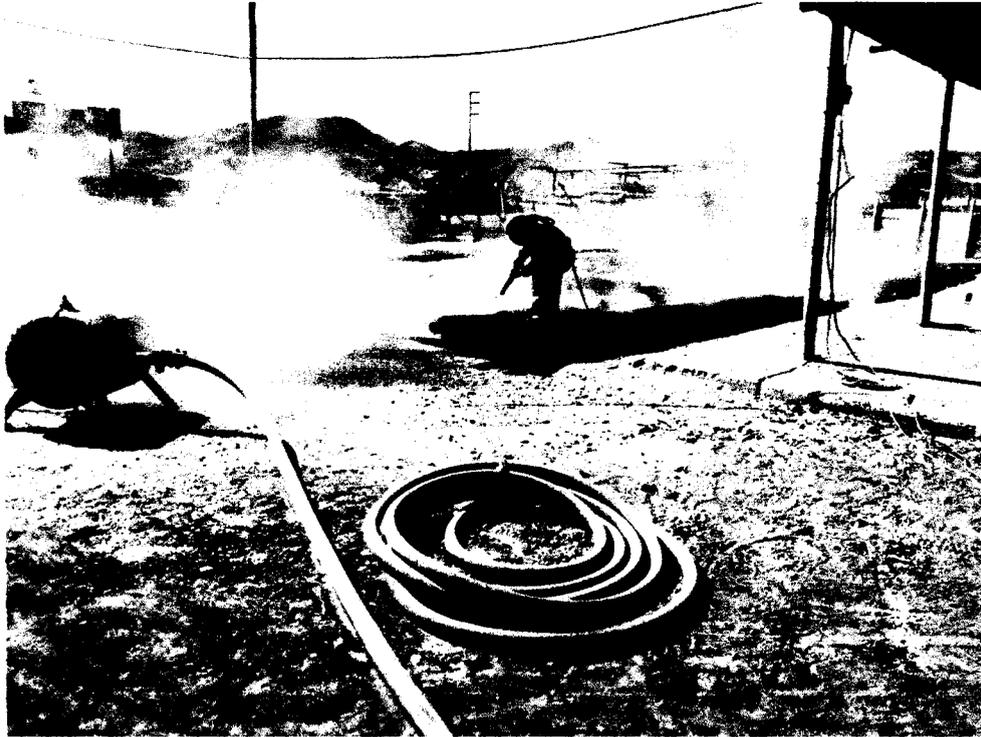
Foto N° 01: Habilitación en taller de elementos de acero (proceso de arenado).
